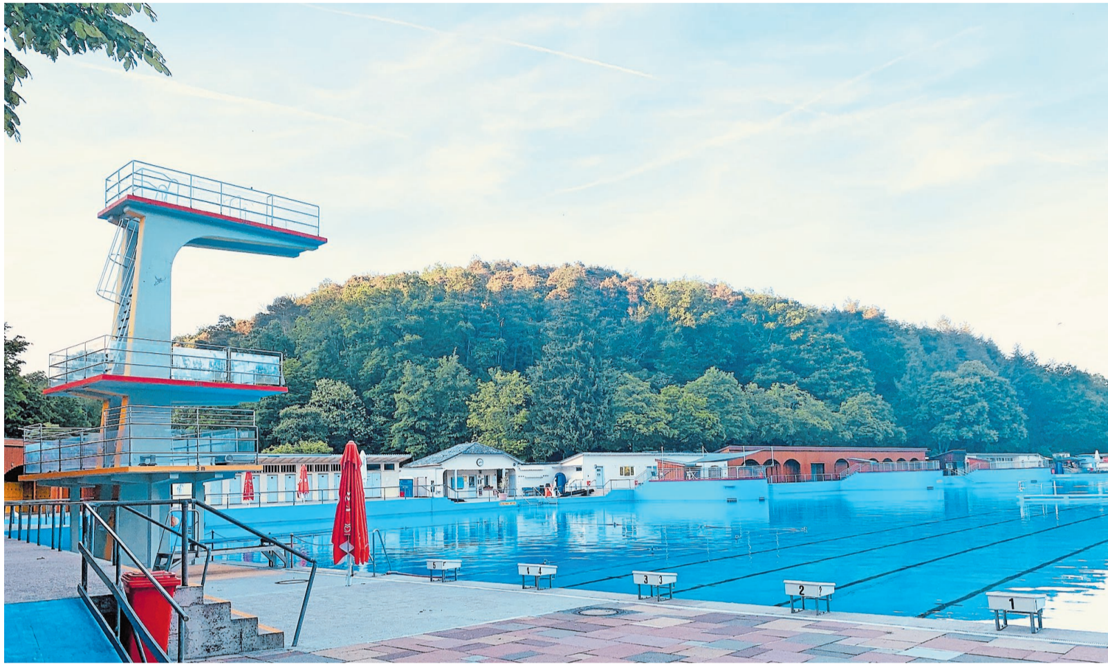
Bis es in der „Wesch“ wieder so aussieht, wird es noch ein paar Tage dauern. Noch ist das Becken nach dem Wasserschaden nicht wieder hergerichtet.
