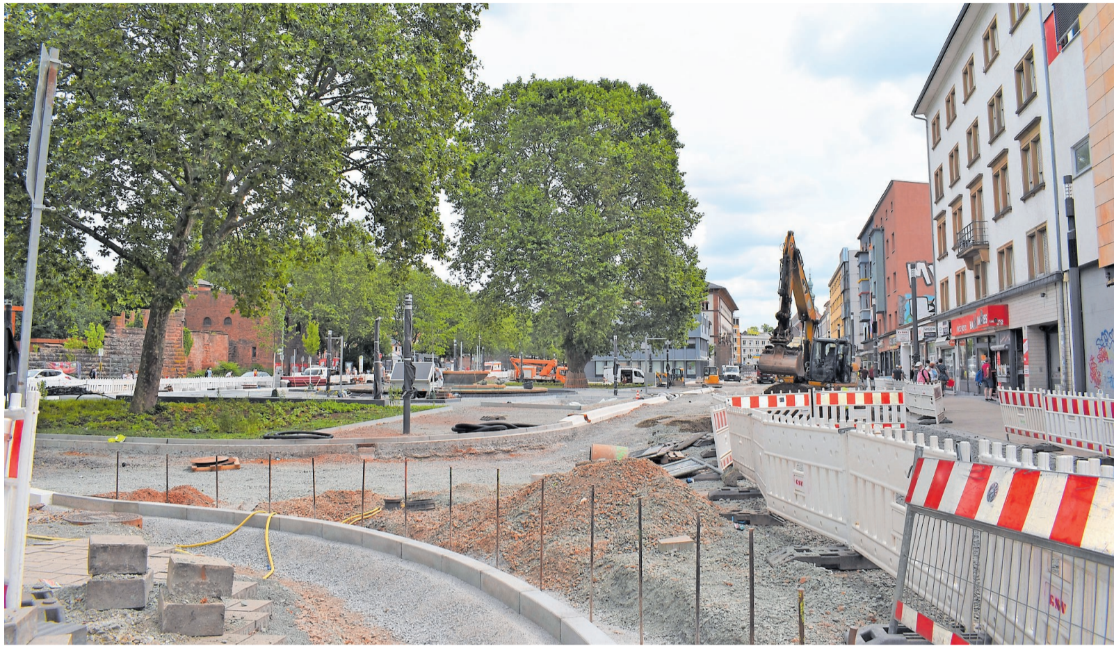
Die Konturen sind eindeutig schon sichtbar. Und die neuen Lichtmasten stehen auch schon.
