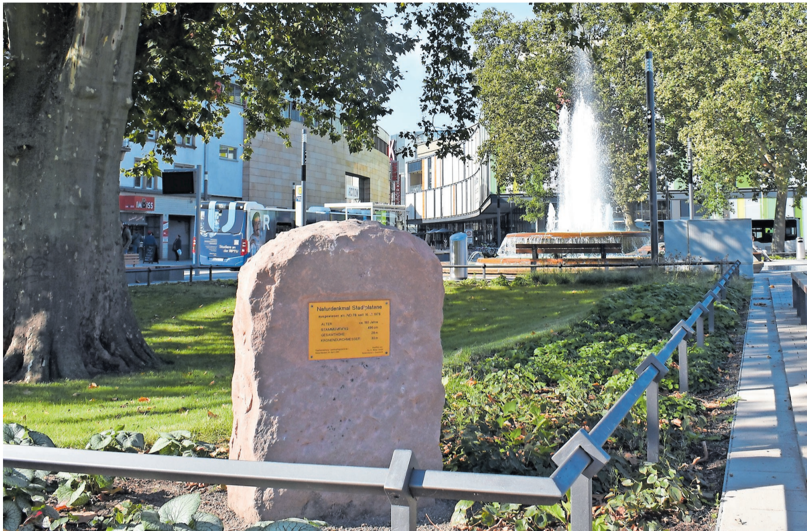
Am letzten Mittwoch nahm die Baustelle in der „Neue Stadtmitte“ einen weiteren großen Schritt. Die Verkehrsfläche zwischen Mall und der Stadtplatane wurde freigegeben und einen Tag später auch der städtische Fackelbrunnen wieder in Betrieb genommen.
