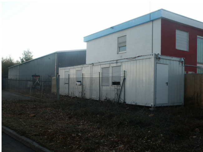
Liebigstraße 13 Bordell (Rotes Haus) Rückwärtiges Gebäude - Lagerhalle (Leerstand)
