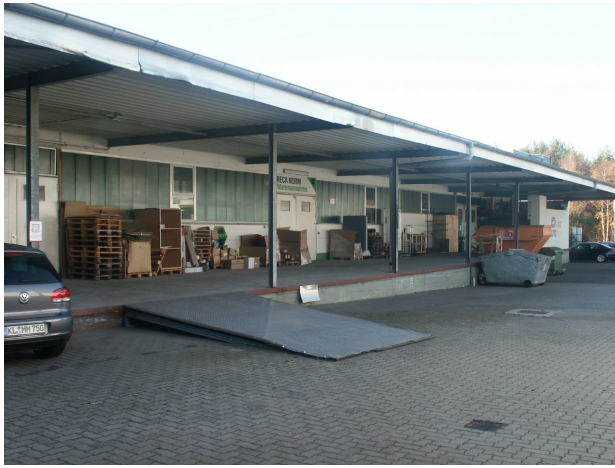
Liebigstraße 3 - Lagerhalle (Hofbereich)
