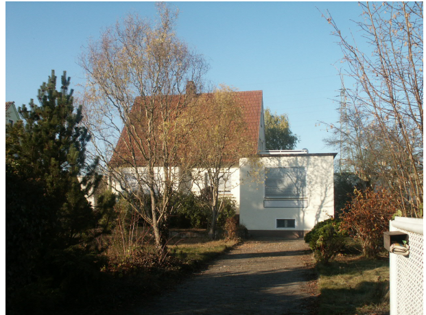
Wohngebäude - Straße Am Wurzelwoog 5
