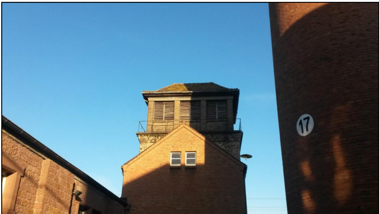
Abb. 4: Gebäudekomplex auf dem Betriebsgelände der Spinnerei Lampertsmühle. Ein Teil der Gebäude weist Spalten und Einflugöffnungen auf, die Dachstühle bestehen z.T. aus Holzverkleidung, wie hier bei Gebäude 23 (Mitte) zu erkennen.
