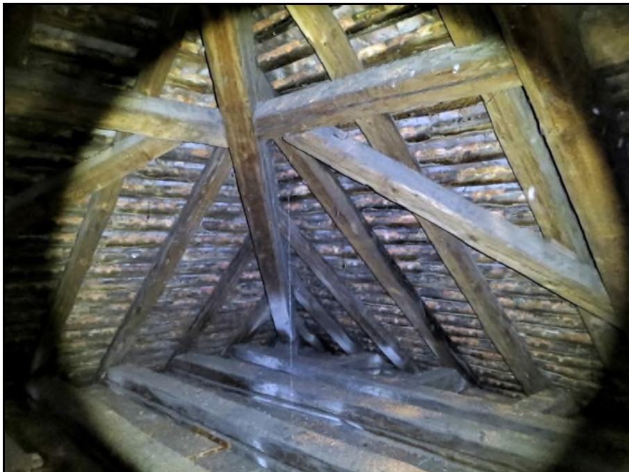
Abb. 7: Typischer Eindruck eines Dachstuhls (hier: Gebäude 26). Es konnten keine Hinweise auf eine Nutzung durch Fledermäuse gefunden werden.
