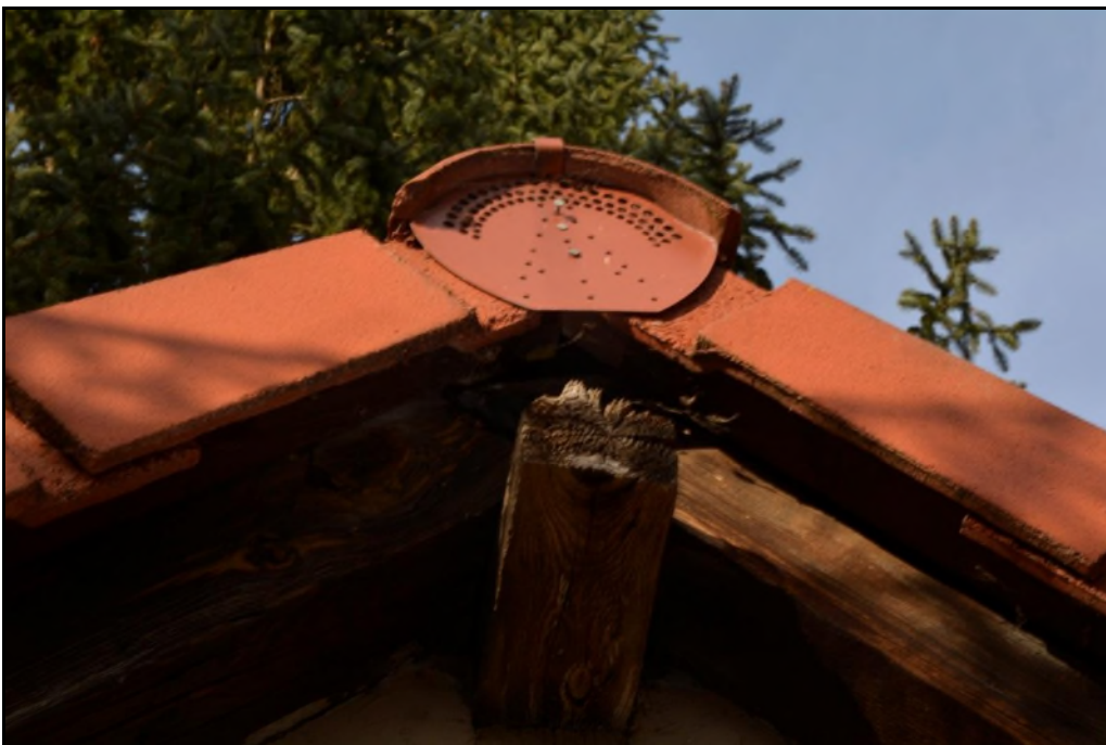
Abb.9: Dachgiebel des an Gebäude 4 angrenzenden Schuppens nahe der Siegelbacher-Str. Es besteht eine potenzielle Einflugmöglichkeit für einzelne Fledermausindividuen direkt am Dachgiebel.
