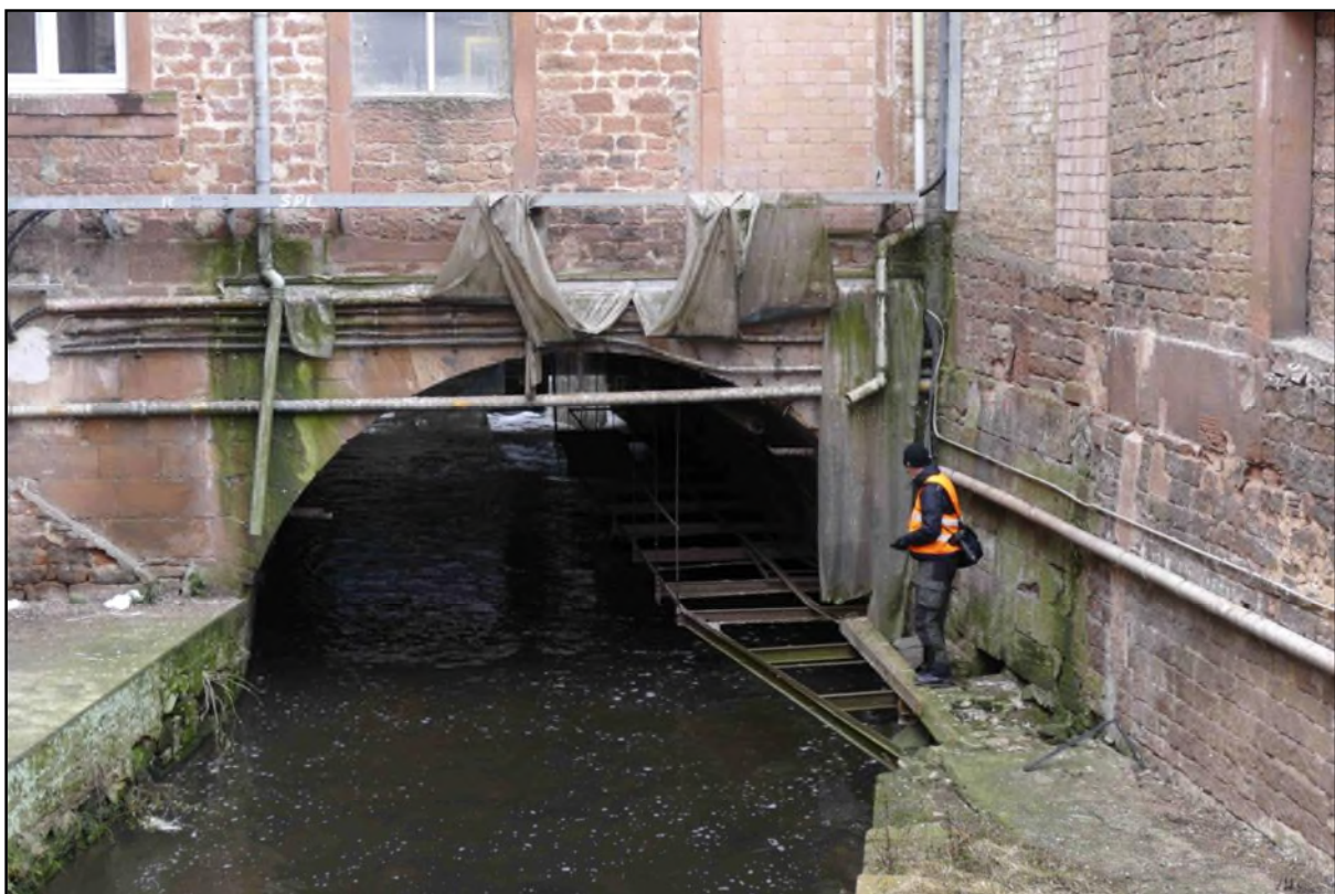
Abb. 5: Das Werksgelände wird vom Mühlgraben durchzogen („Werkskanal“).
