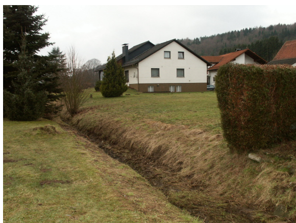
Bestehendes Gebäude im rückwärtigen Bereich Breitenauer Straße 6a
