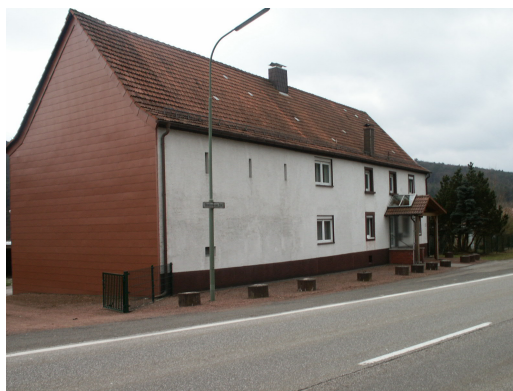
Straßenansicht – Breitenauer Straße 4
