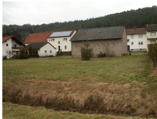
Bestehendes Wirtschaftsgebäude auf dem rückwärtigen Grundstück Breitenauer Straße 10
