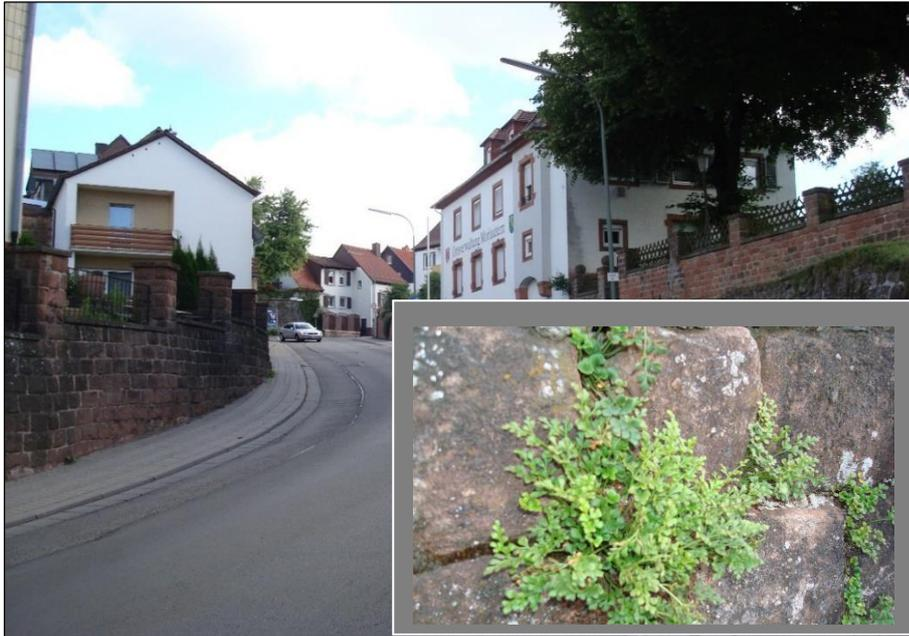
**Abb. 5: Teilabschnitt Mauer Nr. 1 (links) in der Otterberger Straße mit Blick Richtung Norden. In den herausgebrochenen Fugen wächst häufig die Mauerraute (Bildquelle: WSW & Partner, 06/2018)**
