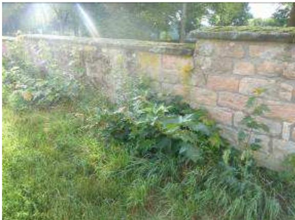
Bei der Friedhofsmauer handelt es sich um eine verfugte Steinmauer. Der Mauerfuß wird abschnittsweise von dem Aufwuchs von Ahornbäumen bedeckt.
