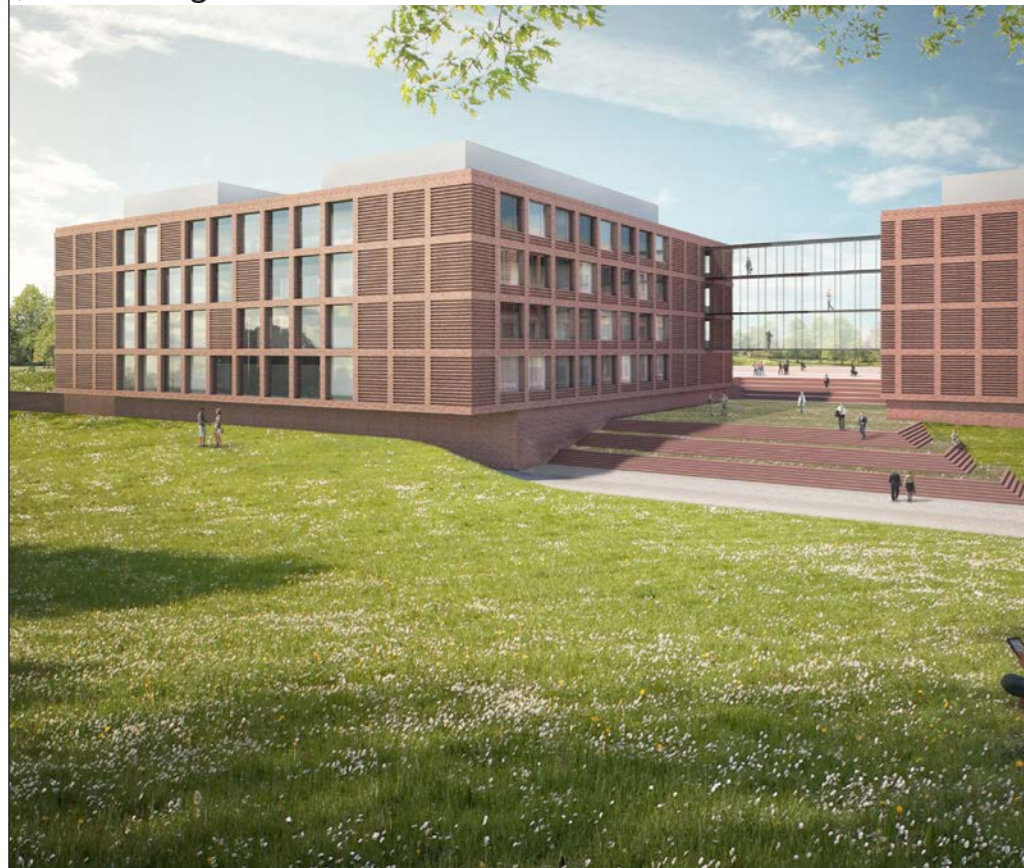
Chemische Institute am Campus Riedberg Frankfurt Goethe-Universität
