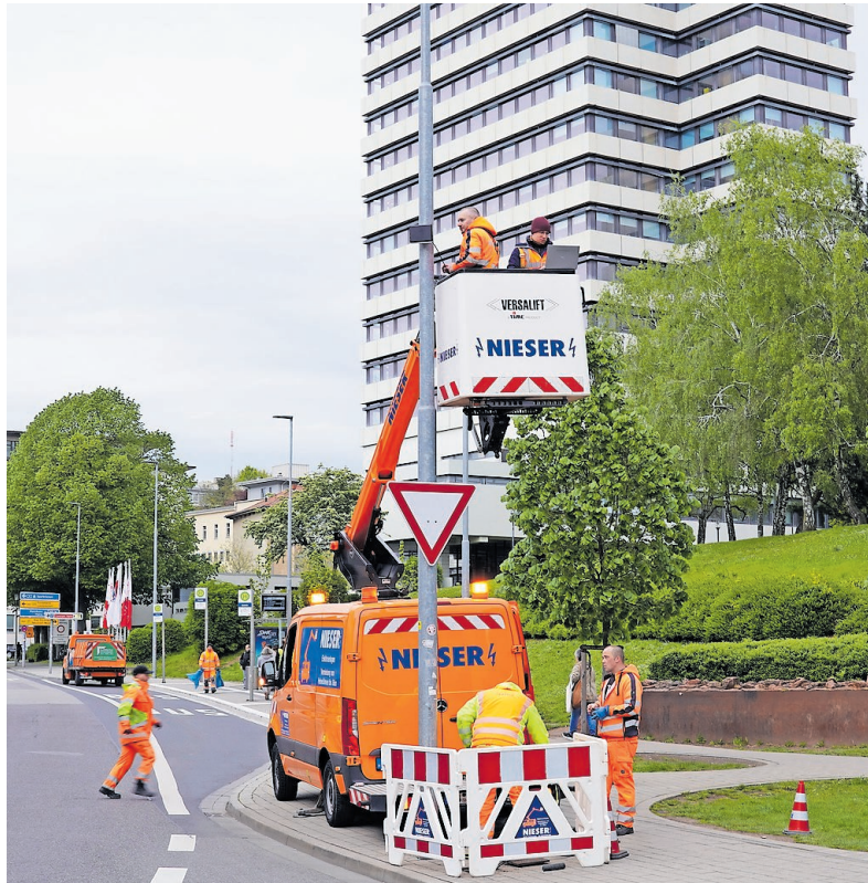
Soll zukünftig für mehr Verkehrssicherheit sorgen: Die innovative Radarsensoren. Hier bei der Installation in der Maxstraße.
