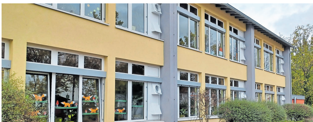
Außenansicht der Grundschule Morlautern vom November 2022, mit bereits verbauten Lüftungsanlagen in den Fenstern
