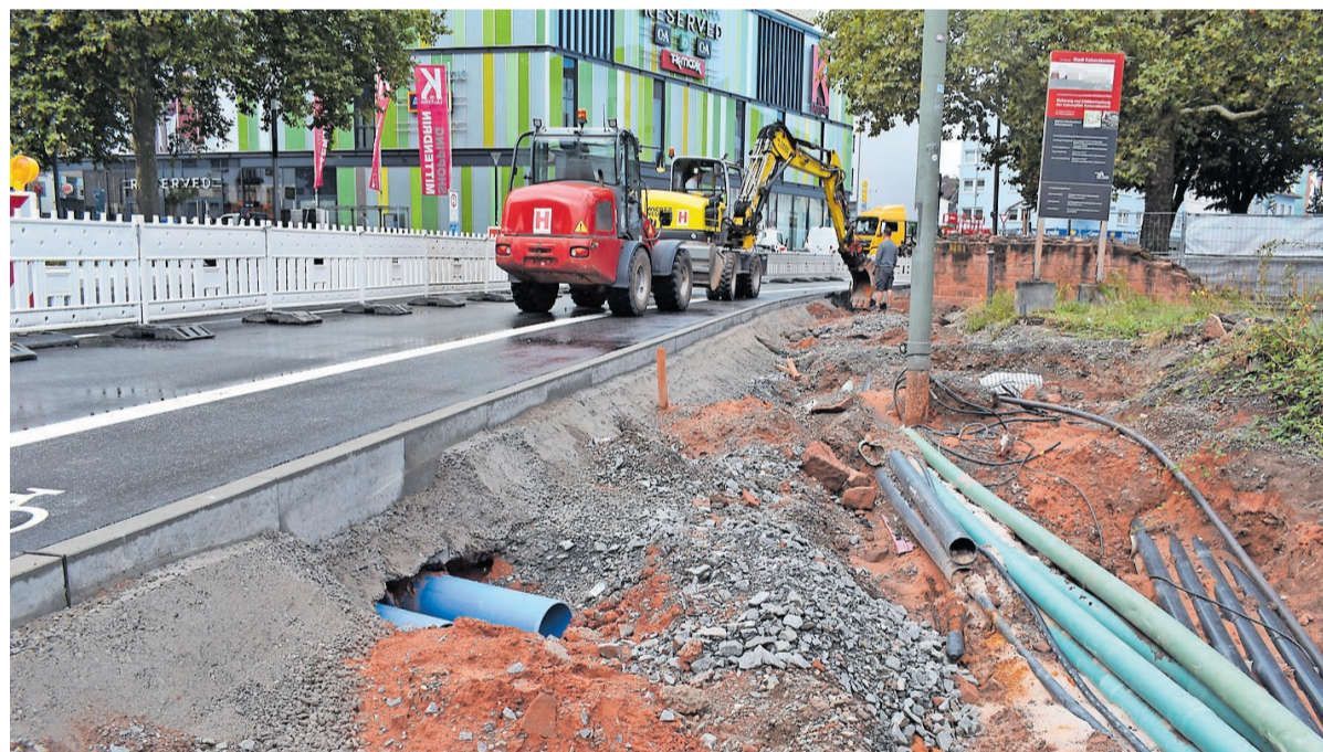
Im Zuge der Bauarbeiten wurden bereits Rohre für die geplante Erlebbarmachung der Lauter gelegt
