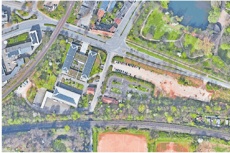
Der Parkplatz am Kniebrech, auf dem die Rettungswache geplant ist, im Luftbild
