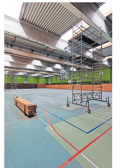
In der Sporthalle des SZ Nord stehen die Gerüste schon
