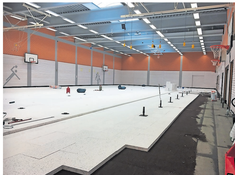
In der Turnhalle der Goetheschule sind die Arbeiten am neuen Hallenboden in vollem Gange. FOTOS (2): PS
