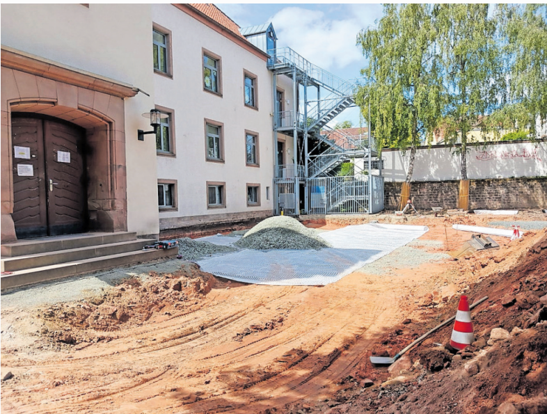
Aktuelle Aufnahmen von der Schulhofsanierung
