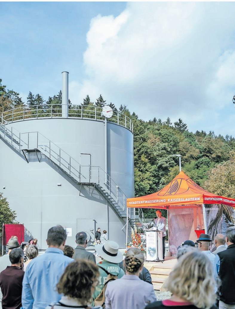
Jörg Zimmermann, Vorstand der Stadtentwässerung, richtete zur Inbetriebnahme feierliche Worte an die Gäste. Im Hintergrund der neue Gasspeicher.
