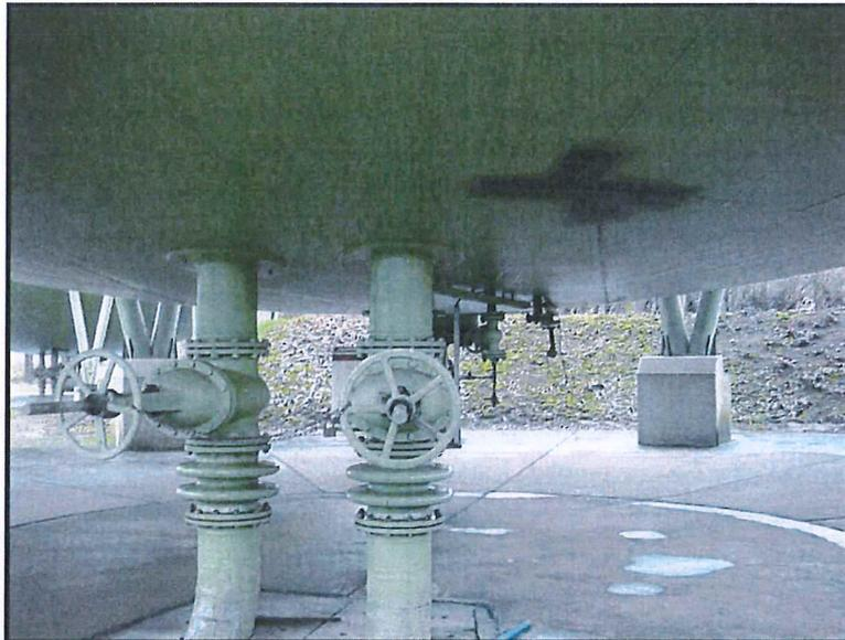
**Abb. 2-2:** Ansicht der Gaszu-/ableitungen (DN300) der Kugelgasbehälter
