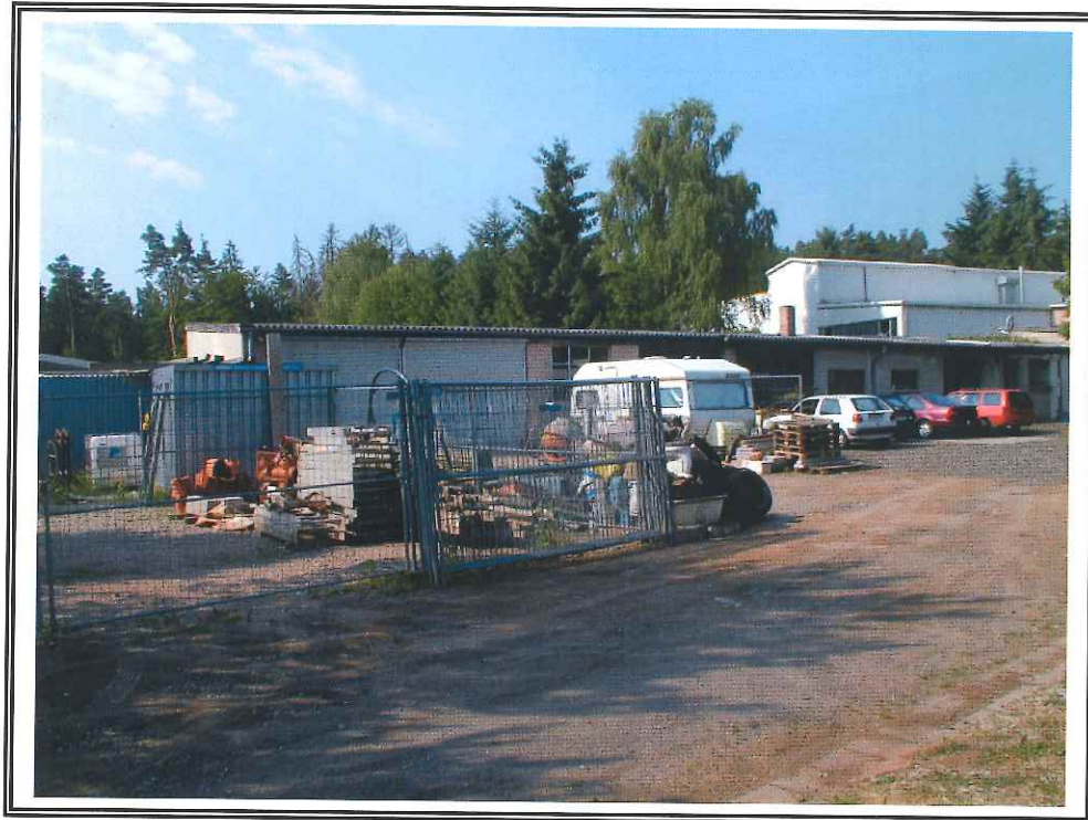
Foto 5: Finkenstraße 57, Lagerhalle und Freifläche
