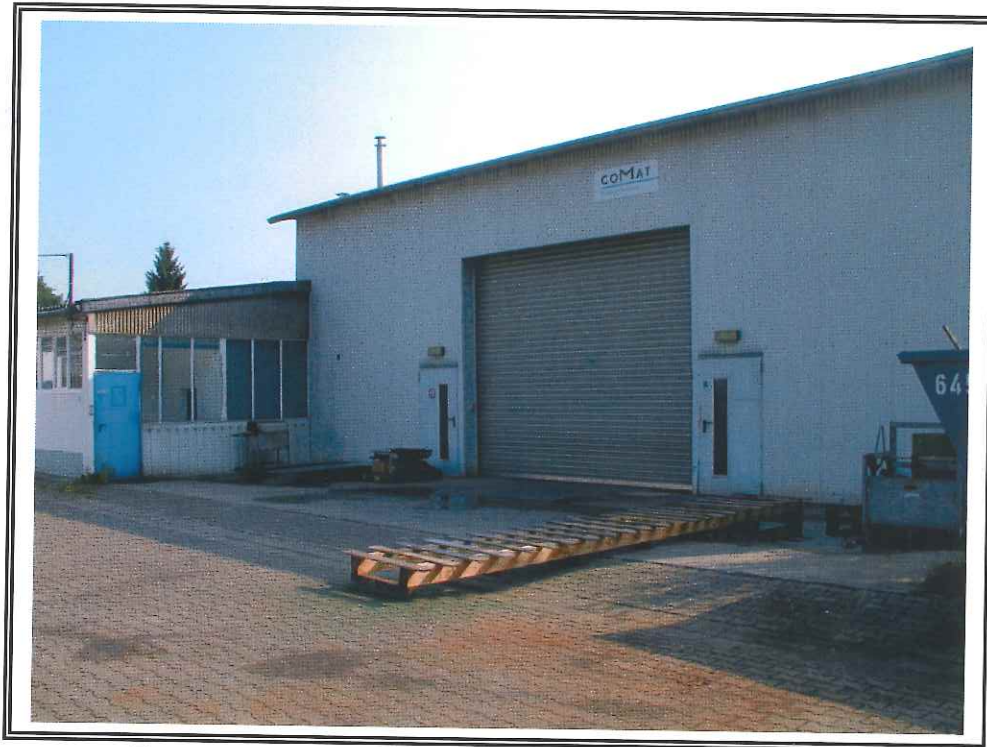
Foto 7: Finkenstraße 59, Lagerhalle Fa.Löwen- Hydraulik Blickrichtung Nord- Nordost
