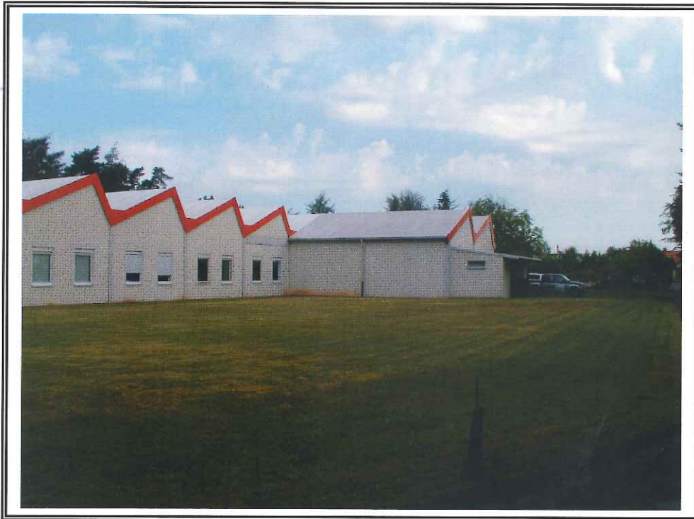
Foto 1: Am Sportplatz 5, Werkhalle mit ehem. Lackier- und Trockenraum, Blickrichtung Nordwest
