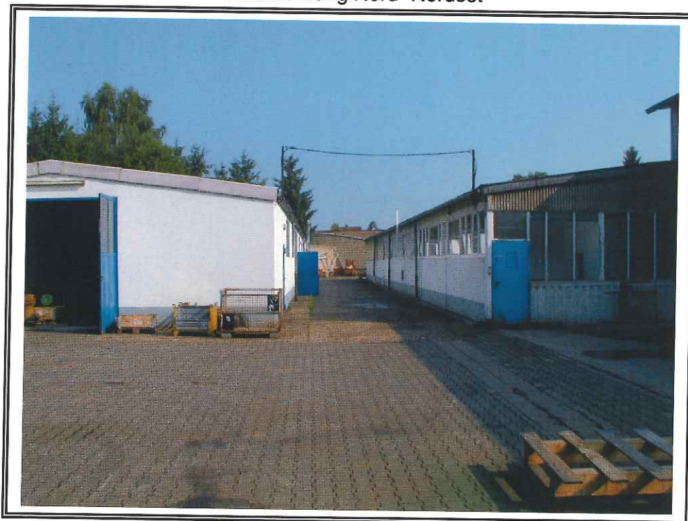
Foto 8: Finkenstraße 59, Montage- und Lagerhalle Fa.Löwen- Hydraulik Blickrichtung Nordwest
