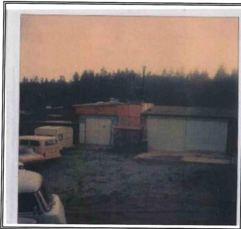
Foto 6: Finkenstraße 57, Lackierhalle und 2 Vorbereitungshallen Aufnahme ca. 1979
