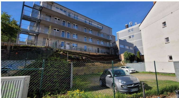
Abbildung 7: Blick von der Mühlstraße auf Turnerstraße 2a und Mühlstraße 57
