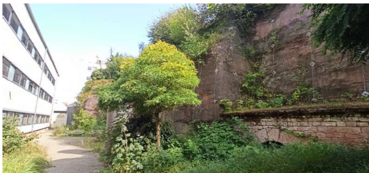
Abbildung 11: Südseite Schoenstraße 9 (Hochschule)
