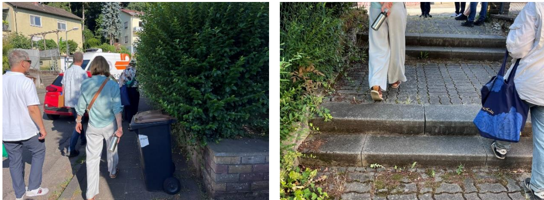
Abbildung 26: Schmale, verstellte Gehwege Am Rabenfels (links), Stufen am Fußweg Richtung Sickinger Straße (rechts)
