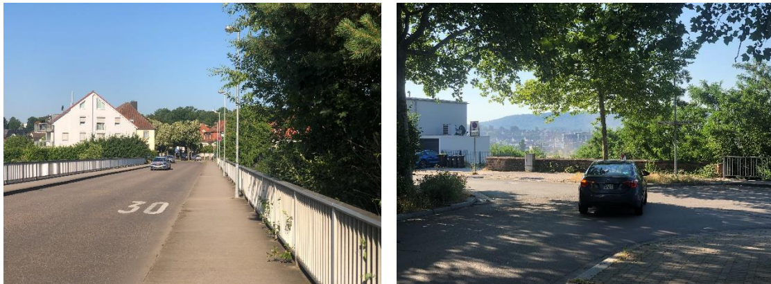
Abbildung 30: Brücke Auf dem Bännjerrück (links), Kreuzung Langenfeldstr./Herzog-von-Weimar-Str. (rechts)
